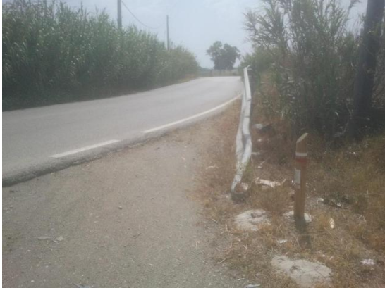
WPT7. Cruce con carretera
