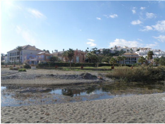
WPT7: Cruce de arroyo Jordana
