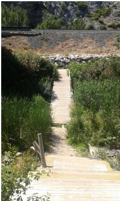
WPT3. Paso del río Guadiaro. Puente derruido y fin de coincidencia con PR-A 253
