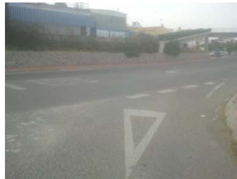
WPT4. Cruce carretera
