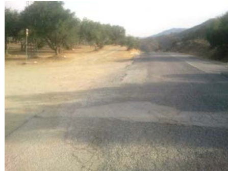
WPT4. Inicio de coincidencia con carretera
