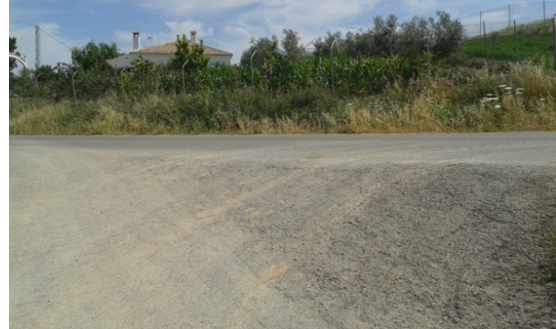
WPT2. Inicio tramo de carretera MA-478
