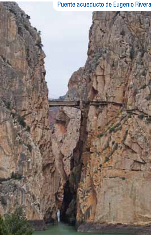
Puente acueducto de Eugenio Rivera
