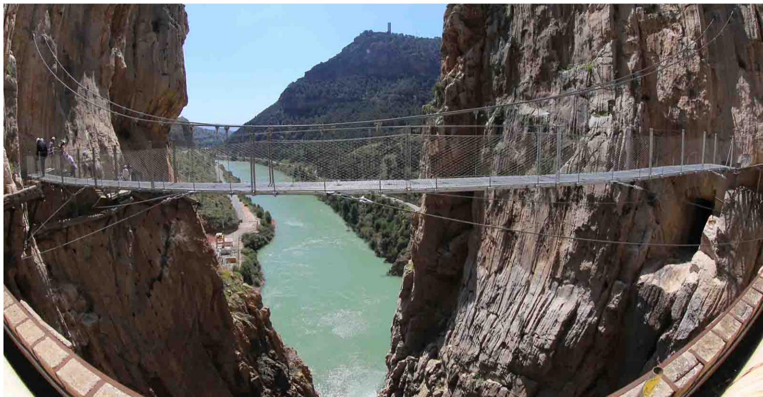
Vista de una de las pasarelas que atraviesa el Desfiladero de los Gaitanes.
