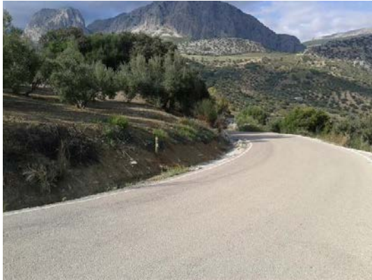
WPT7. Puerto Sabar, inicio carretera A-7204
