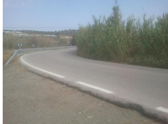
WPT8. Cruce con carretera
